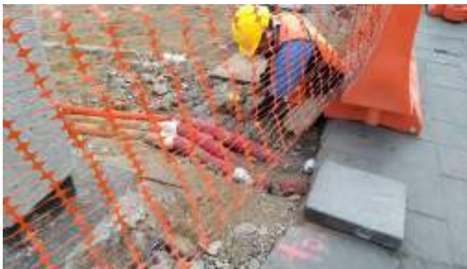
Demolición de banquetas
