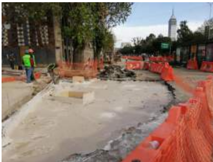
Demoliciones en banquetas
