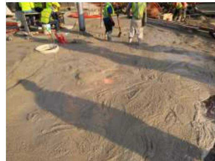
Colocación de relleno fluido
