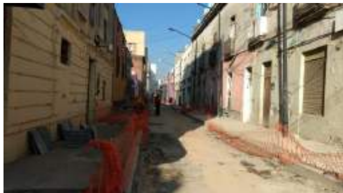
Demolición de carpeta asfáltica
