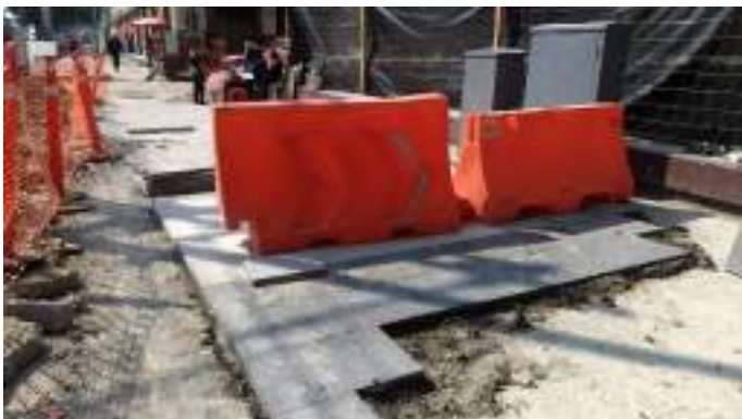
Colocación de recinto
