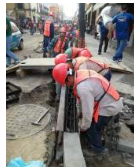
Armado de guarniciones
