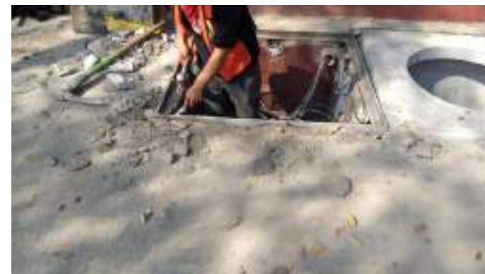
Demolición de registro
