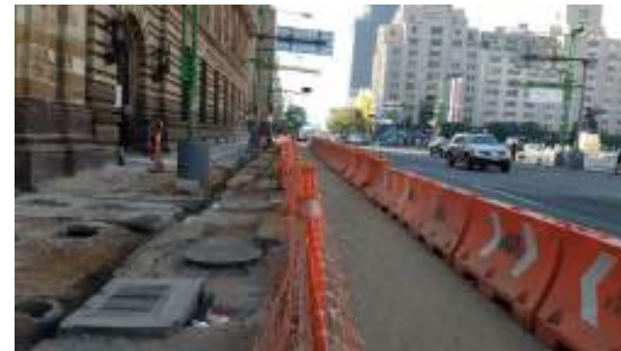
Demolición de banquetas y guarniciones
