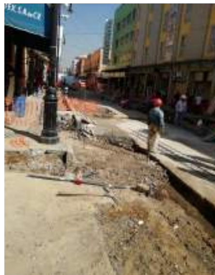
Preparación de guarniciones
