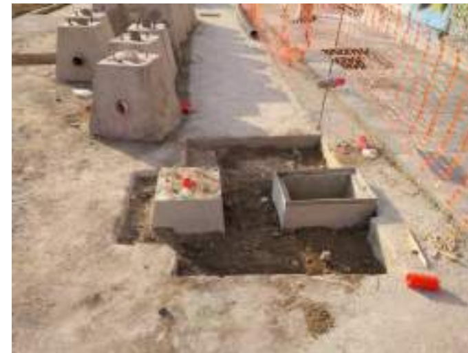
Colado de bases
