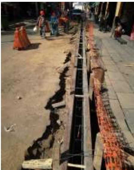
Cimbrado de guarniciones
