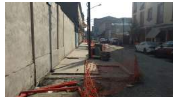
Avance colocación de recinto
