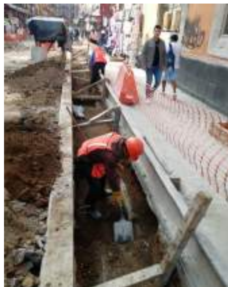
Preparación de guarniciones
