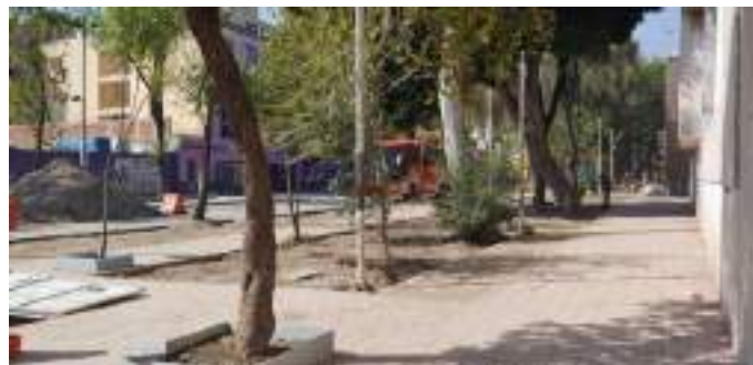
Avance de Obra
