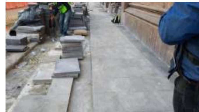
Retiro de recinto
