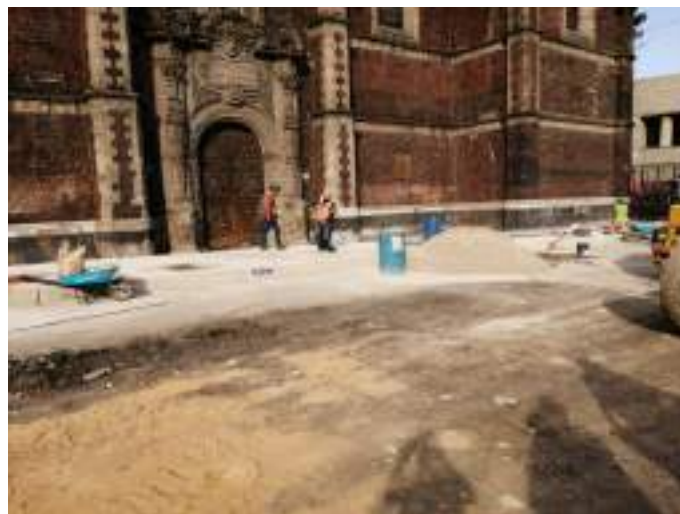
Trabajos frente a Iglesia Santa Veracruz
