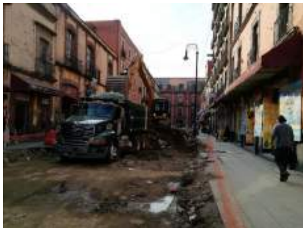
Retiro de demoliciones
