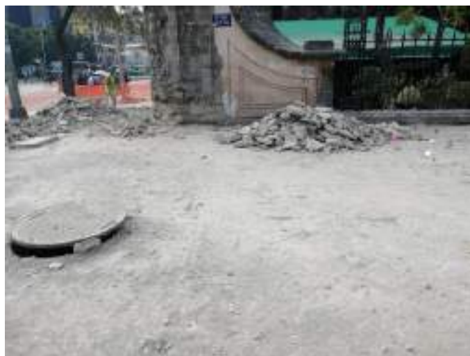
Demoliciones de banquetas
