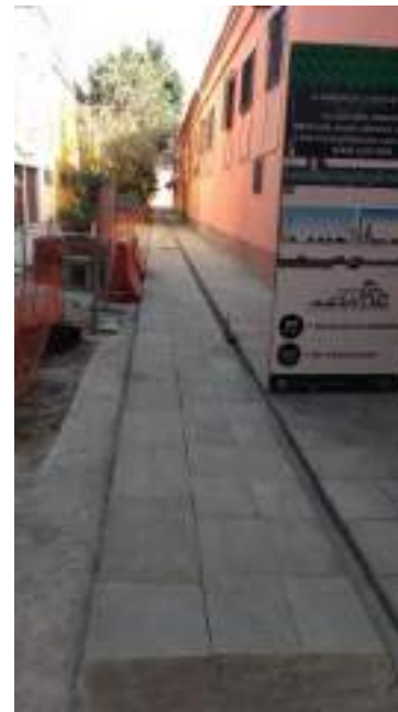
Colocación de recinto
