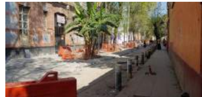
Colocación de bolardos
