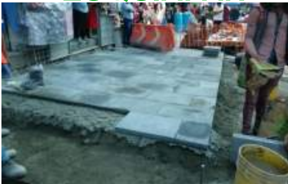
Colocación de recinto
