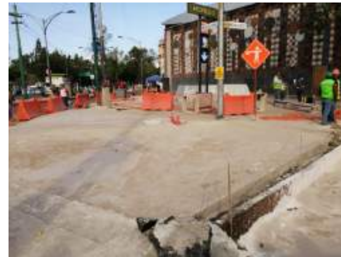
Confinamiento de areas
