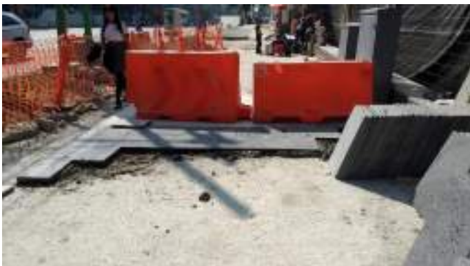
Colocación de recinto
