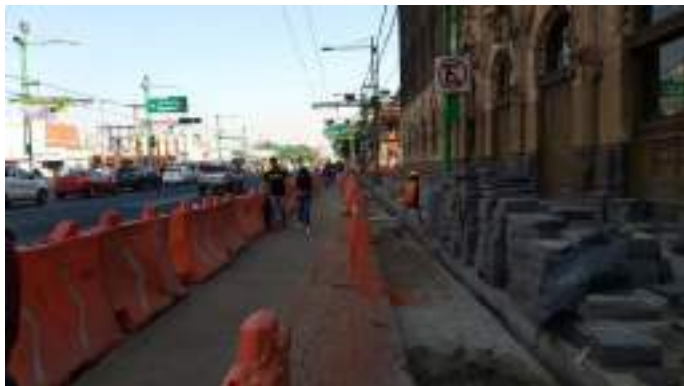
Colocación de recinto
