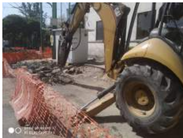
Demolición de carpeta asfáltica
