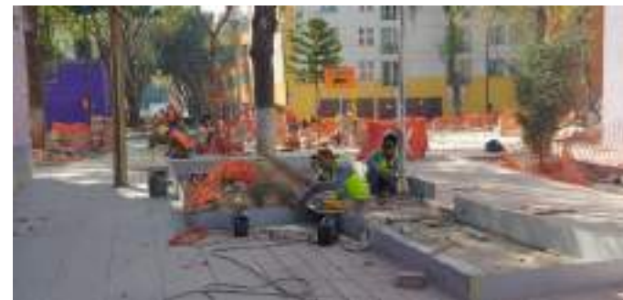
Colocación de placas para Jardineras
