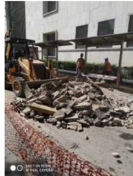
Carga de demoliciones
