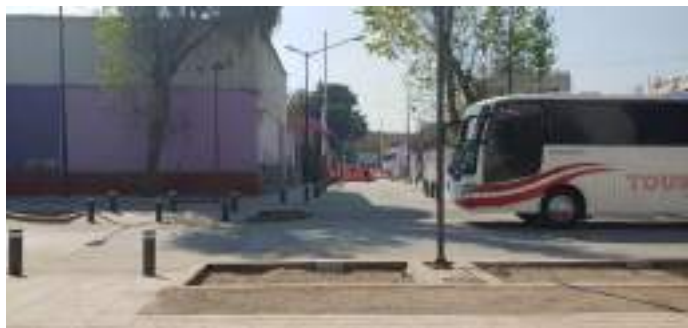
Avance de obra
