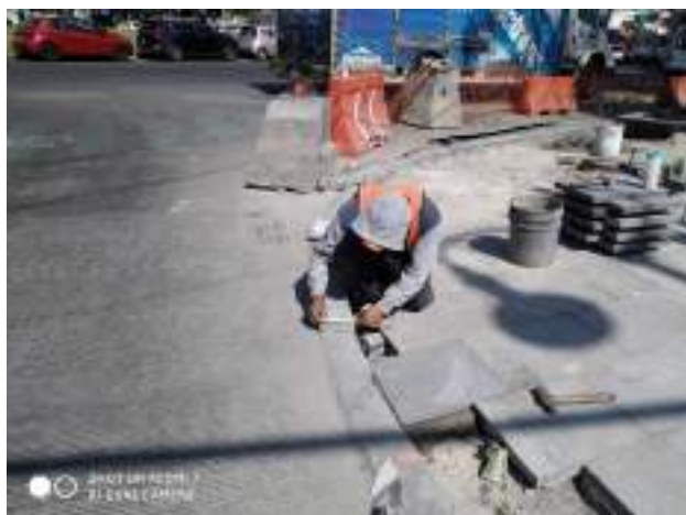
Colocación de recinto
