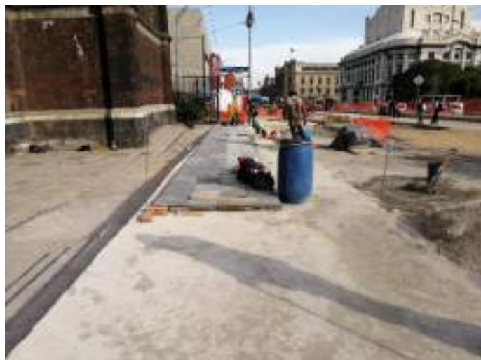
Colocación de recinto
