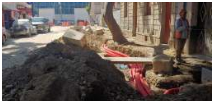
Trabajos de canalización para luminarias
