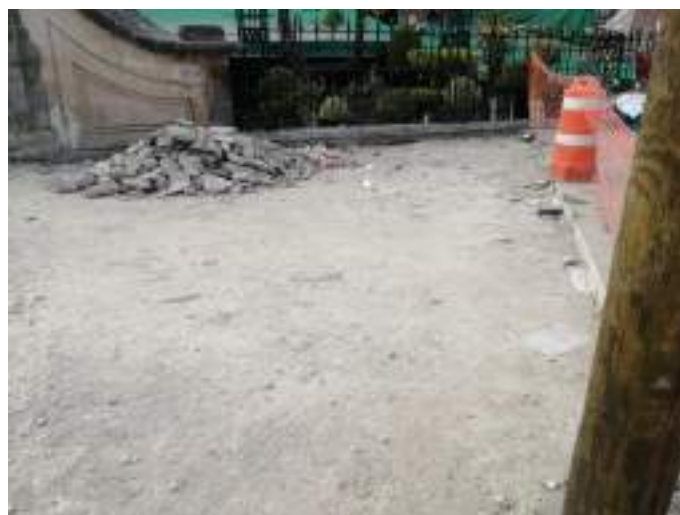
Confinamiento de áreas de trabajo
