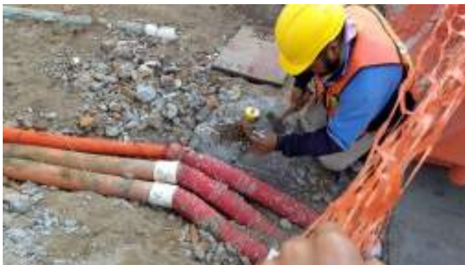
Demolición de banquetas
