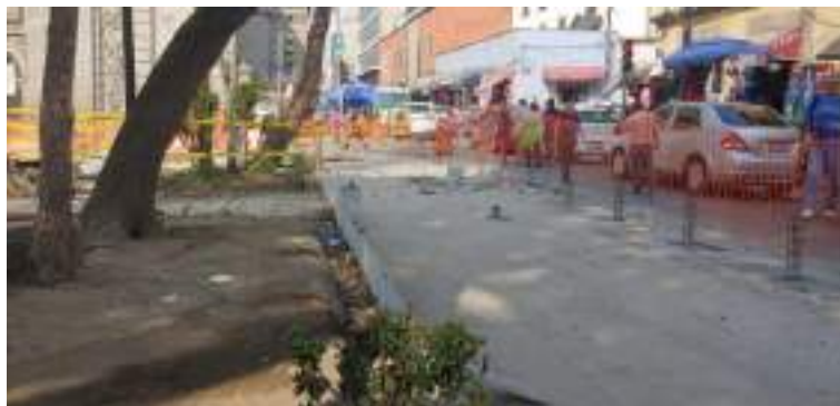
Acabado en banqueta Plaza Loreto
