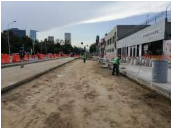
Preparación de base para concreto
