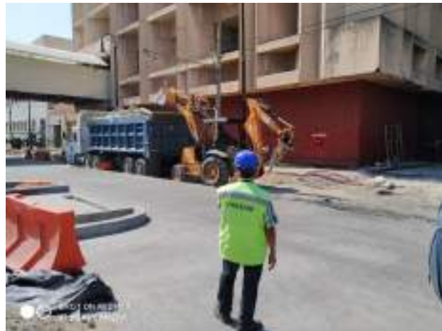
Carga de demoliciones
