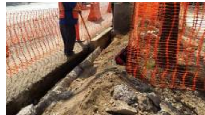
Demolición de banquetas y guarniciones
