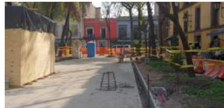
Confinamiento de trabajos Plaza Loreto
