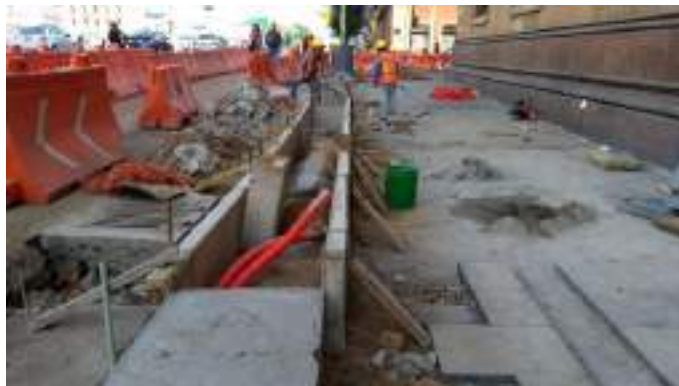
Demolición de banquetas
