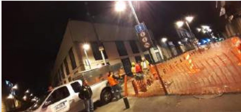
Retiro de escombros en Republica de Ecuador entre Comonfort y Allende de la colonia Centro.
