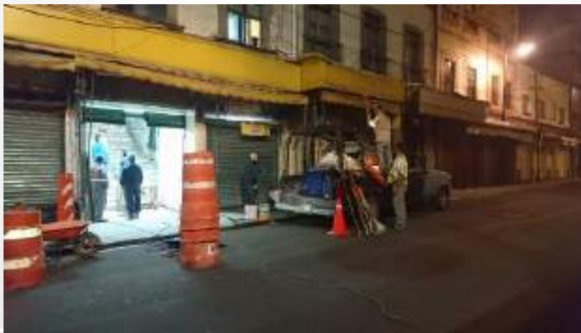
Trabajos por parte de personal de Aguas de México para la rehabilitación de ramal de agua en Republica de Colombia #88, colonia Centro.
