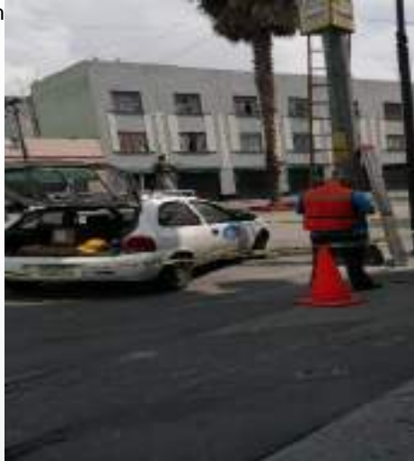
instalación de antena Wifi y migración a fibra Plaza Garibaldi, Colonia Centro Histórico, Alcaldía Cuauhtémoc
