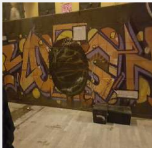
Propiedad dañada ubicada en la calle de Margil y Zapata de la colonia Centro.
