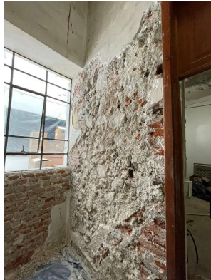
Liberaciones en muros de mampostería.
