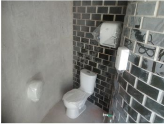
COLOCACION DE MUEBLES Y ACCESORIOS DE BAÑO EN AREAS DE SANITARIOS DEL EDIFICIO (EJES 3-4/B-C) Y AREAS DE COMERCIO (EJES 7-B Y F-2)
