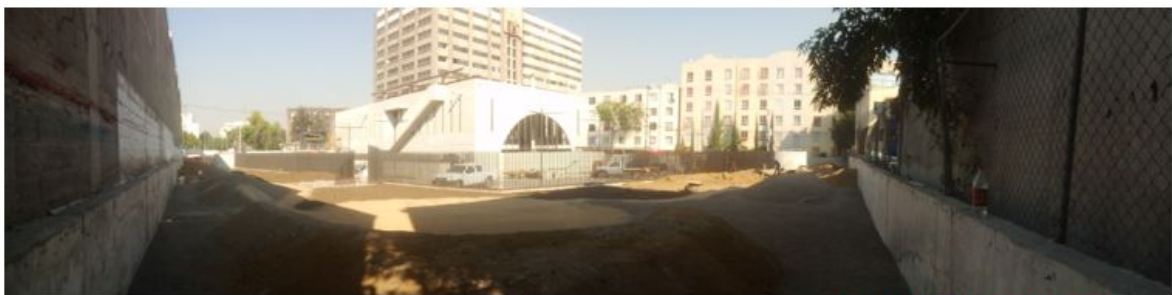
VISTA PANORAMICA NORESTE
