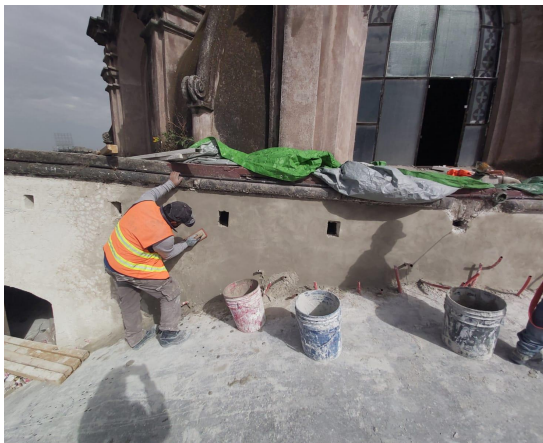
Integración de aplanados en muros de extradós.
