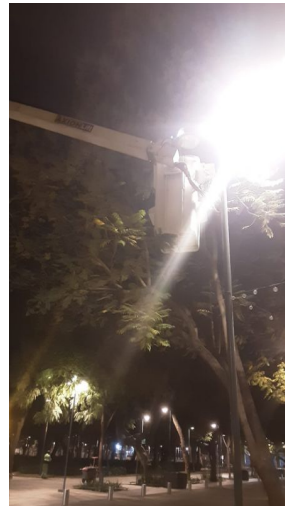
SE REALIZA CAMBIO DE BALASTRO.
