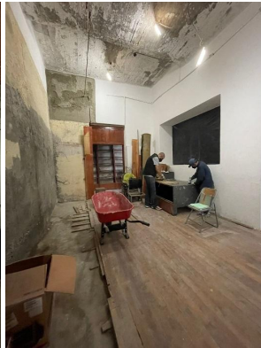
Reintegración de aplanados finos en muros interiores.
