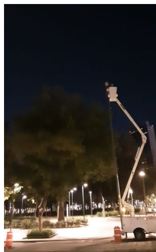
SE REALIZA CAMBIO DE BALASTRO.
