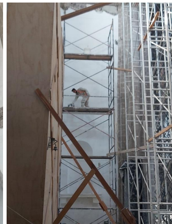
Integración de aplanados finos en muros interiores.
