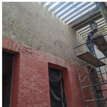
Reposición de aplanado grueso y puertos de inyección en muro de pasillo de planta alta.
