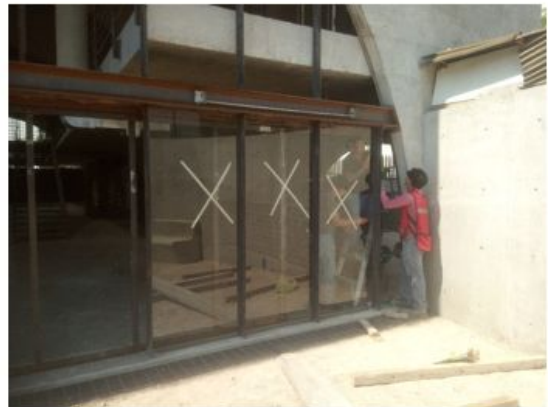
COLOCACION DE CRISTALERIA EN PUERTAS P-01 Y P-02 (EJES B/1-6 Y C/1-6) Y PORTÓN CORREDIZO (EJES 6/B-C) DE LA PLANTA BAJA
