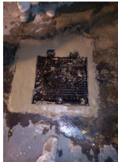
Cambio de tapa y limpieza de coladera pluvial en Arcos de Belem esq. Dr. Vertiz
