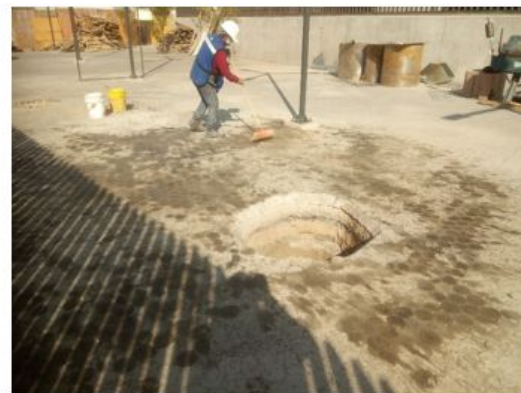
SE REALIZAN TRABAJOS DE LIMPIEZA EN OBRA
