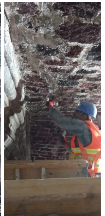
Consolidación de intradós de bóveda.
