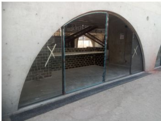
COLOCACION DE CRISTALERIA EN PUERTAS P-01 Y P-02 (EJES B/1-6 Y C/1-6) Y PORTÓN CORREDIZO (EJES 6/B-C) DE LA PLANTA BAJA
