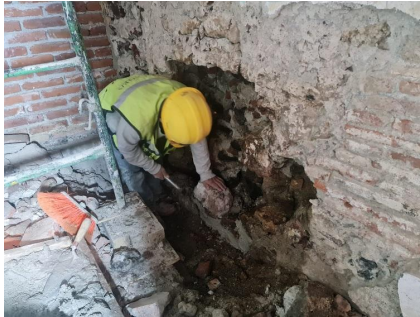
Consolidación de muros de mampostería.
