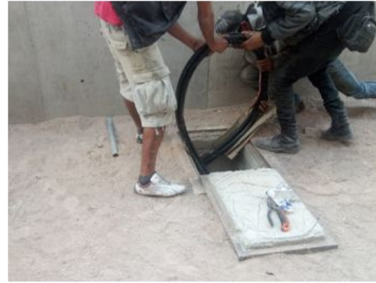
COLOCACION DE ALIMENTADOR PRINCIPAL CON CABLE DE COBRE CALIBRE 500KCMIL
