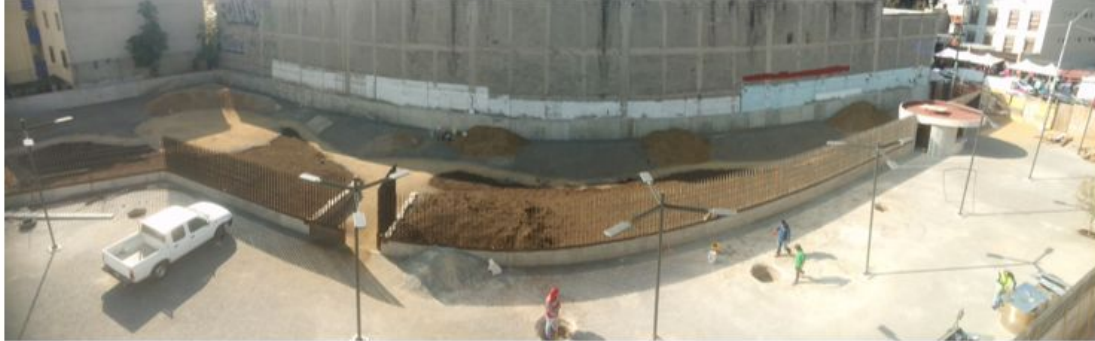
TENDIDO DE TIERRA PARA AFINE DE NIVELES EN PARQUE (EJES 7-8/E-F)
