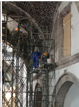
Integración de aplanados finos en muros interiores.
