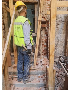
Liberaciones en muros de mampostería.
