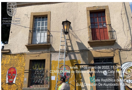
Reparación de luminarias en calle República de Perú
