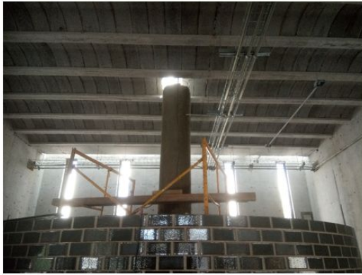
ELABORACION DE CHIMENEA EN AREA DE COCINA DE LA PLANTA BAJA (EJES 5-B)
