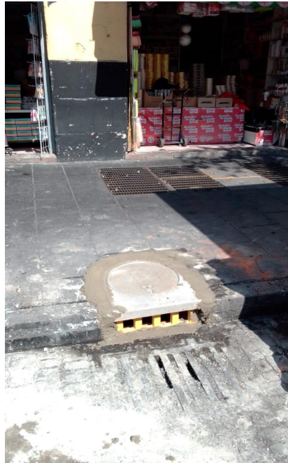
Ramón Corona esq. Roldán . Colocación de tapa de registro pluvial
