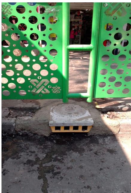
Circunvalación entre Misioneros y San Pablo colocación de registro pluvial
