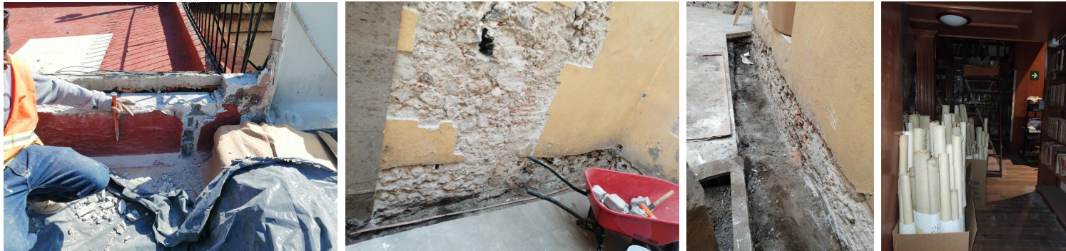
Trabajos preliminares, consolidación de fisuras y movimiento de mapas históricos.
