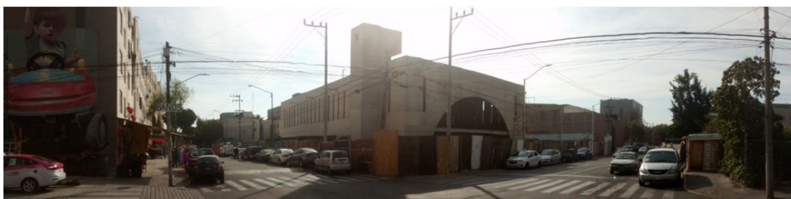
VISTA PANORAMICA SUROESTE
