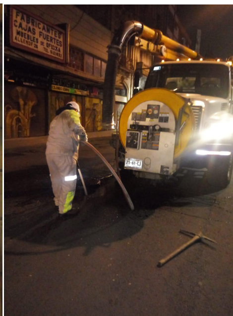
Allende esq Donceles Desazolve de 20 m de atarjea 1 pozos de visitas y 3 coladera pluviales ; retiro de 0.5 m3 de azolve
