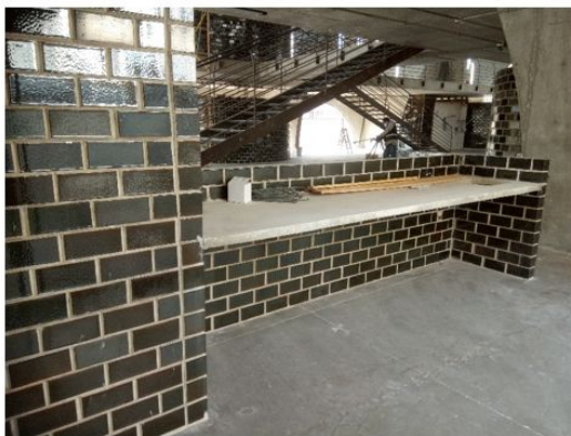
ELABORACION DE MUROS INTERIORES EN EDIFICIO (EJES 1-6/B-C) Y AREAS DE COMERCIO (EJES 7-B Y F-2), A BASE DE TABIQUE ESMALTADO SANTA JULIA 10X10X20CM. COLOR VERDE PLATA
