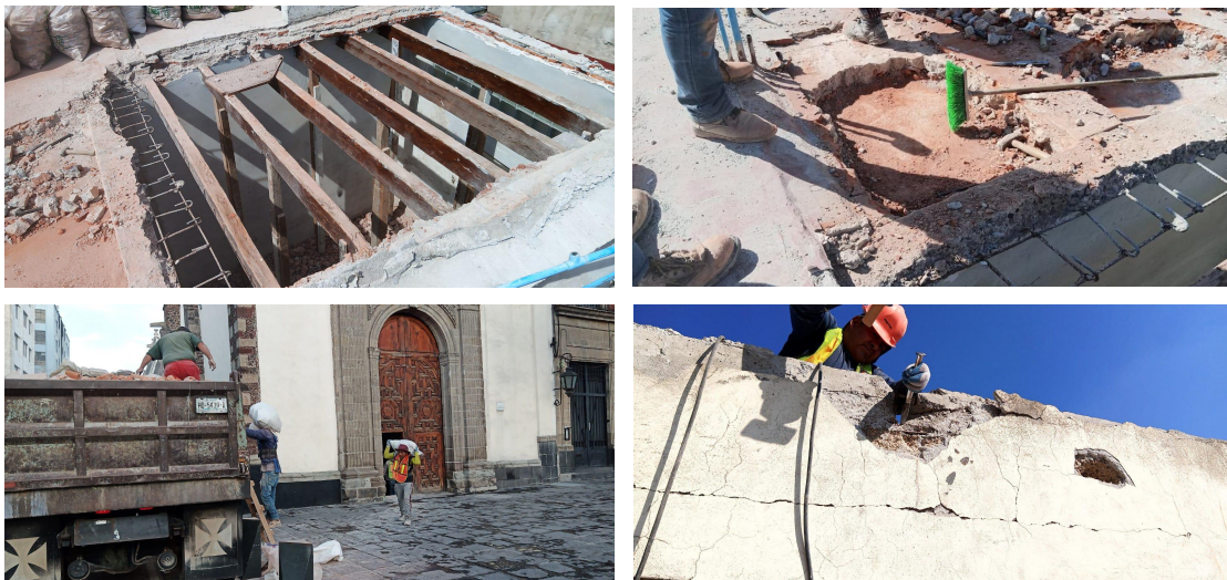
Renovación de sistemas de entepiso, acarreo de residuos.
