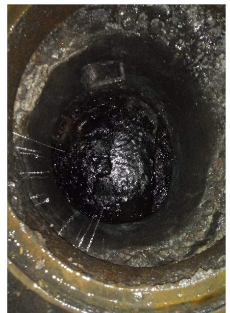
Allende esq Donceles Desazolve de 20 m de atarjea 1 pozos de visitas y 3 coladera pluviales ; retiro de 0.5 m3 de azolve
