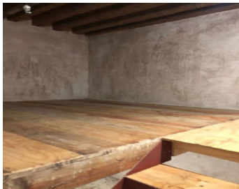
LIMPIEZA Y TRATAMIENTO DE TABLONES Y VIGAS CON PRESERVADOR PARA COMBATIR LOS INSECTOS XILOFAGOS EN TAPANCO.
