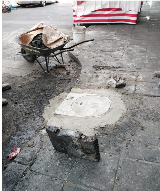
Rep. de Brasil esq. Rep de Honduras, sustitución de coladera pluvial, de Fierro colado por Policoncreto
