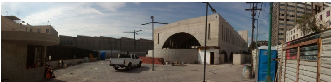
VISTA PANORAMICA SURESTE
