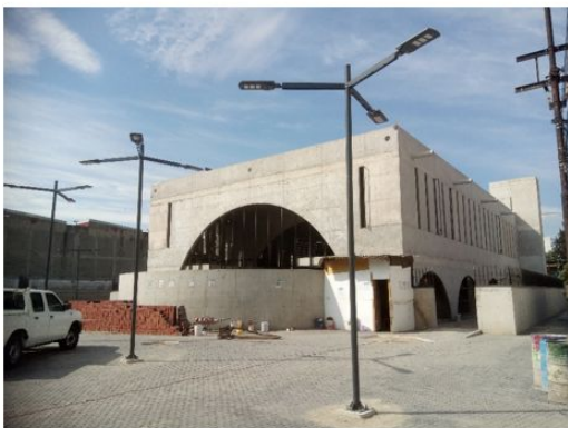
COLOCACION DE POSTES Y LUMINARIAS EN PLAZA
