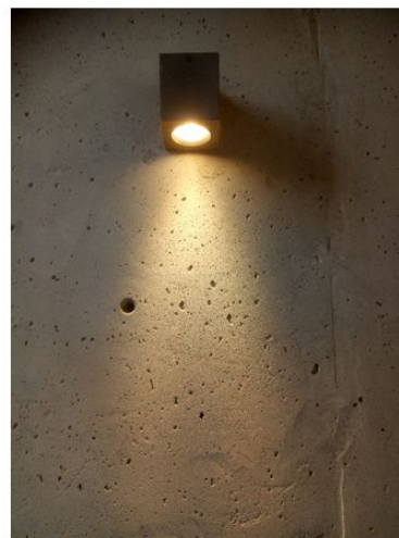
COLOCACION DE LUMINARIAS EN INTERIOR DEL EDIFICIO (EJES 1-6/B-C)
