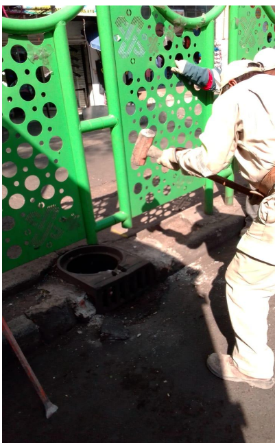
Circunvalación entre Misioneros y San Pablo colocación de registro pluvial
