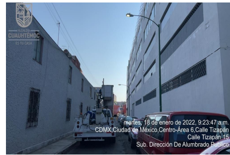
Reparación de alumbrado en calle Tizapán
