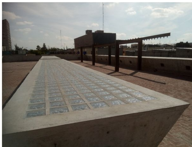
VISTA PANORAMICA DE LA AZOTEA
