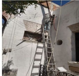
REINTEGRACIÓN DE APLANADOS EN FACHADA Y PINTURA
