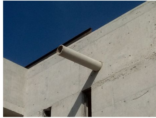
ELABORACION DE GARGOLAS DE CONCRETO ARMADO EN PRETILES DE AZOTEA (EJES 1-6/B-C)
