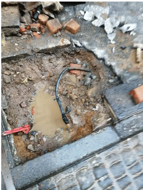
Arreglo de fuga de agua en toma domiciliaria en Correo mayor esq Venustiano Carranza
