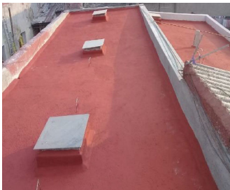
IMPERMEABILIZACIÓN Y COLOCACIÓN DE DOMOS EN CUBIERTA
