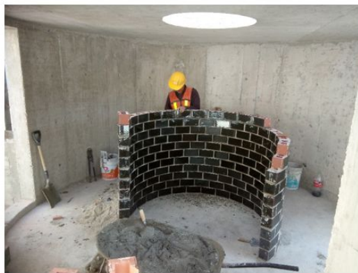
ELABORACION DE MUROS INTERIORES EN EDIFICIO (EJES 1-6/B-C) Y AREAS DE COMERCIO (EJES 7-B Y F-2), A BASE DE TABIQUE ESMALTADO SANTA JULIA 10X10X20CM. COLOR VERDE PLATA
