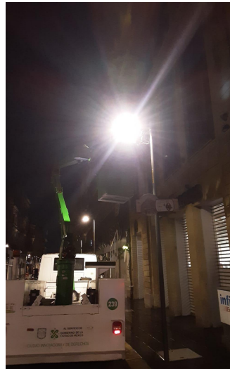
SE REALIZA CAMBIO DE BALASTRO
