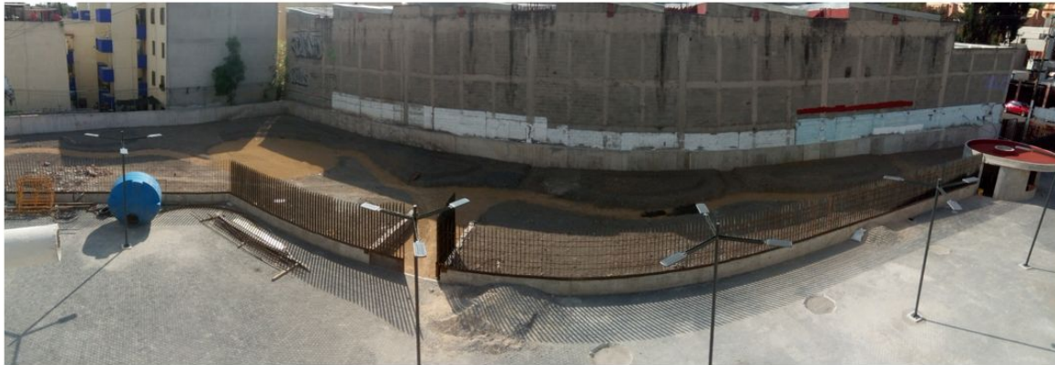
CONFORMACIÓN DE NIVELES EN JARDÍN Y HUERTO CON MATERIAL PRODUCTO DE LA EXCAVACIÓN (EJES 7-8/E-F)
