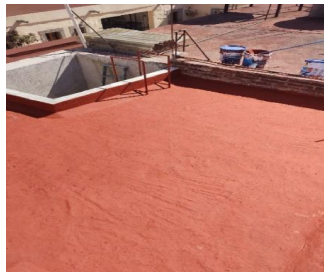
IMPERMEABILIZACIÓN DE CUBIERTA E INTEGRACIÓN DE CUBO DE ILUMINACIÓN Y VENTILACION
