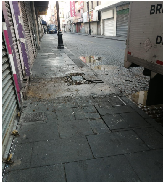
Arreglo de fuga de agua en toma domiciliaria en Correo mayor esq Venustiano Carranza
