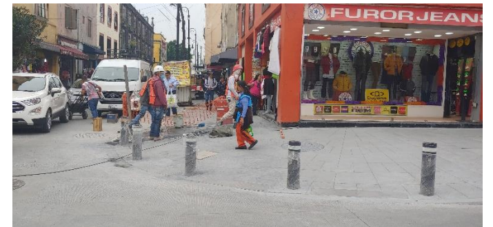
Colocación de bolardos en Calle Soledad
