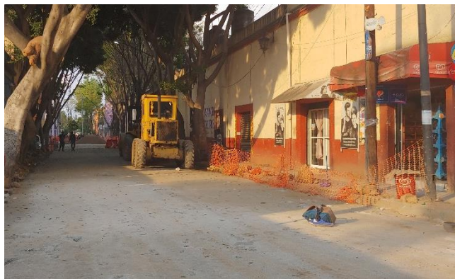
Colado de Relleno Fluido en Galeana Sur
