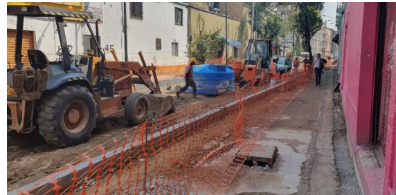
Avance en Calle Javier Mina
