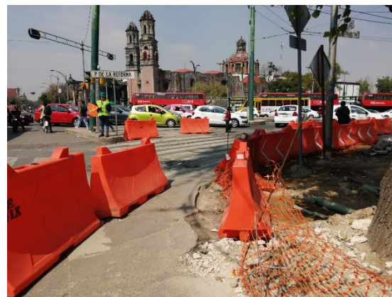
Demolición de banquetas y guarnición en Av. Hidalgo y Paseo de la Reforma
