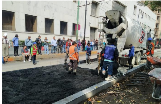
Colado de Relleno Fluido y MR-45 en lado Oriente de Valerio Trujano
