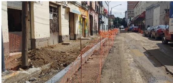
Confinamiento Calle Pensador Mexicano
