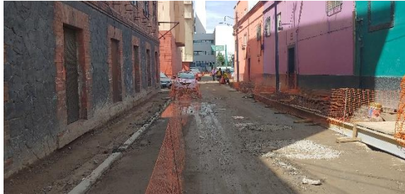
Paso Peatonal Calle Pensador Mexicano
