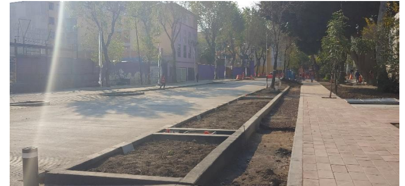
Avance Calle Violeta
