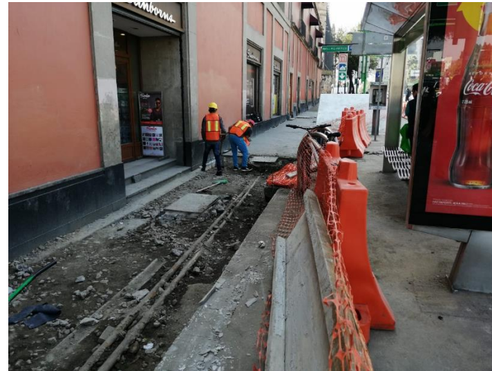
Demolición de Banquetas
