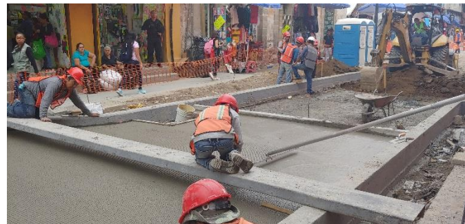
Colado de MR-45 en vialidad en Calle Soledad
