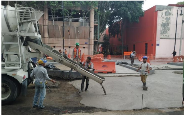
Colado de Relleno Fluido y MR-45 en lado Oriente de Valerio Trujano
