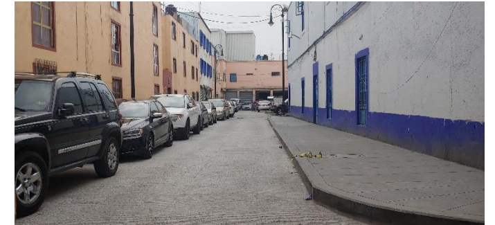
Avance de obra en Callejón de Lecheras
