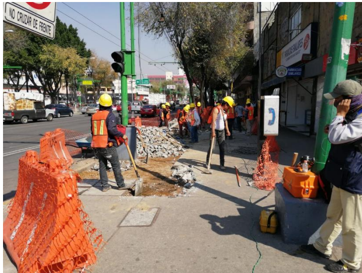
Demolición de banquetas y guarniciones
