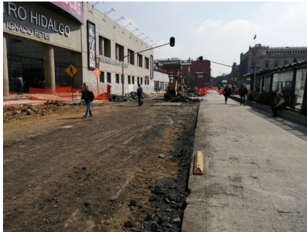
Demolición de carpeta Asfáltica del tramo de calle 2 de Abril a Eje Central
