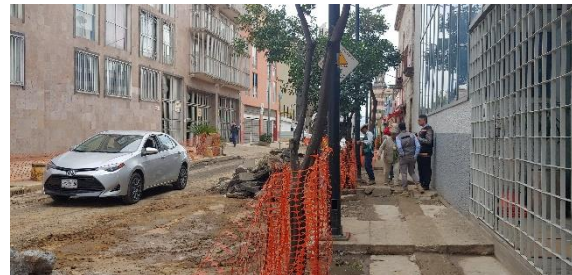
Paso Peatonal Calle Javier Mina
