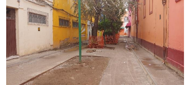
Avance 3er Callejón de San Juan de Dios
