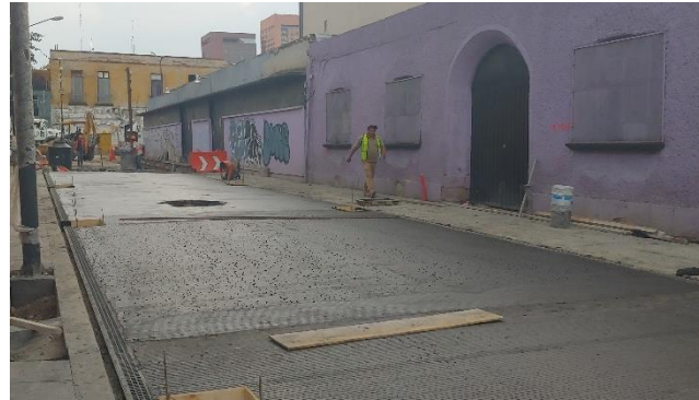
Colado de MR-45 en Riva Palacio Sur
