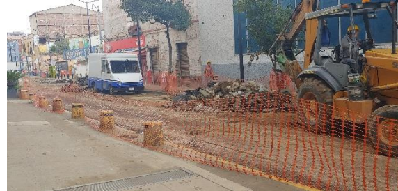
Confinamiento en Calle Javier Mina
