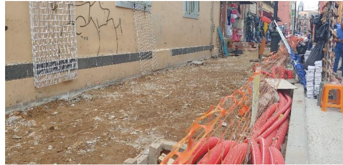
Demolición de banqueta en Calle Soledad
