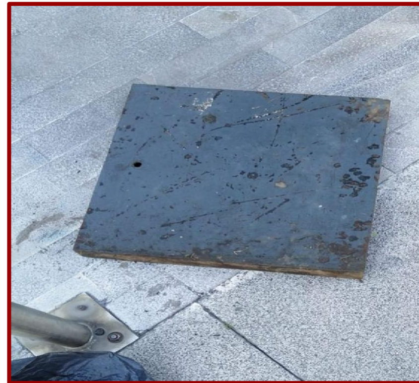
UNA TAPA DE REGISTRO DE CABLEADO DEL ALUMBRADO PÚBLICO, DE APROXIMADAMENTE 50 POR 50 CENTÍMETROS, USADA.
